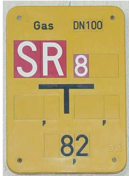
Kennzeichnung eines Saugrohres
